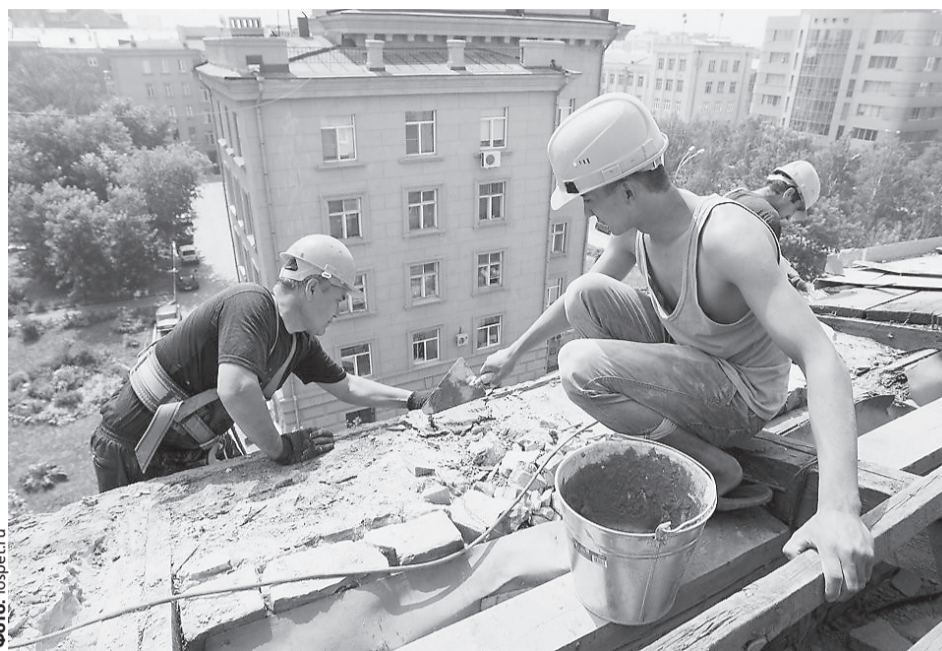
В 2018 году комплексный ремонт выполнен на 1106 домах.
