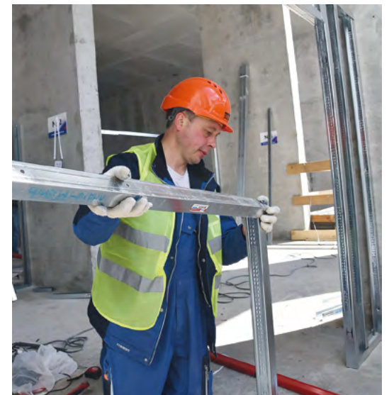
▲ На Среднем Урале прошли конкурсы профессионального мастерства среди строителей — «Строймастер» и «Славим человека труда!». Соревнования состоялись на действующей строительной площадке ЖК «Нагорный» в Екатеринбурге. Всего в конкурсе приняли участие 50 строителей из 24 компаний. Фото: Борис Ярков
