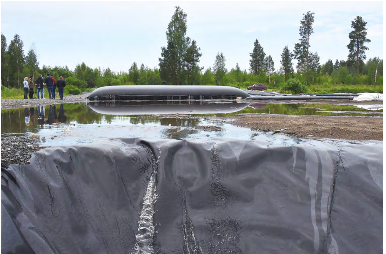
▲ На Черноисточинском водохранилище специалисты приступили к выемке донных отложений. За два года планируется извлечь около 500 тысяч кубометров ила. Фото: Борис Ярков
