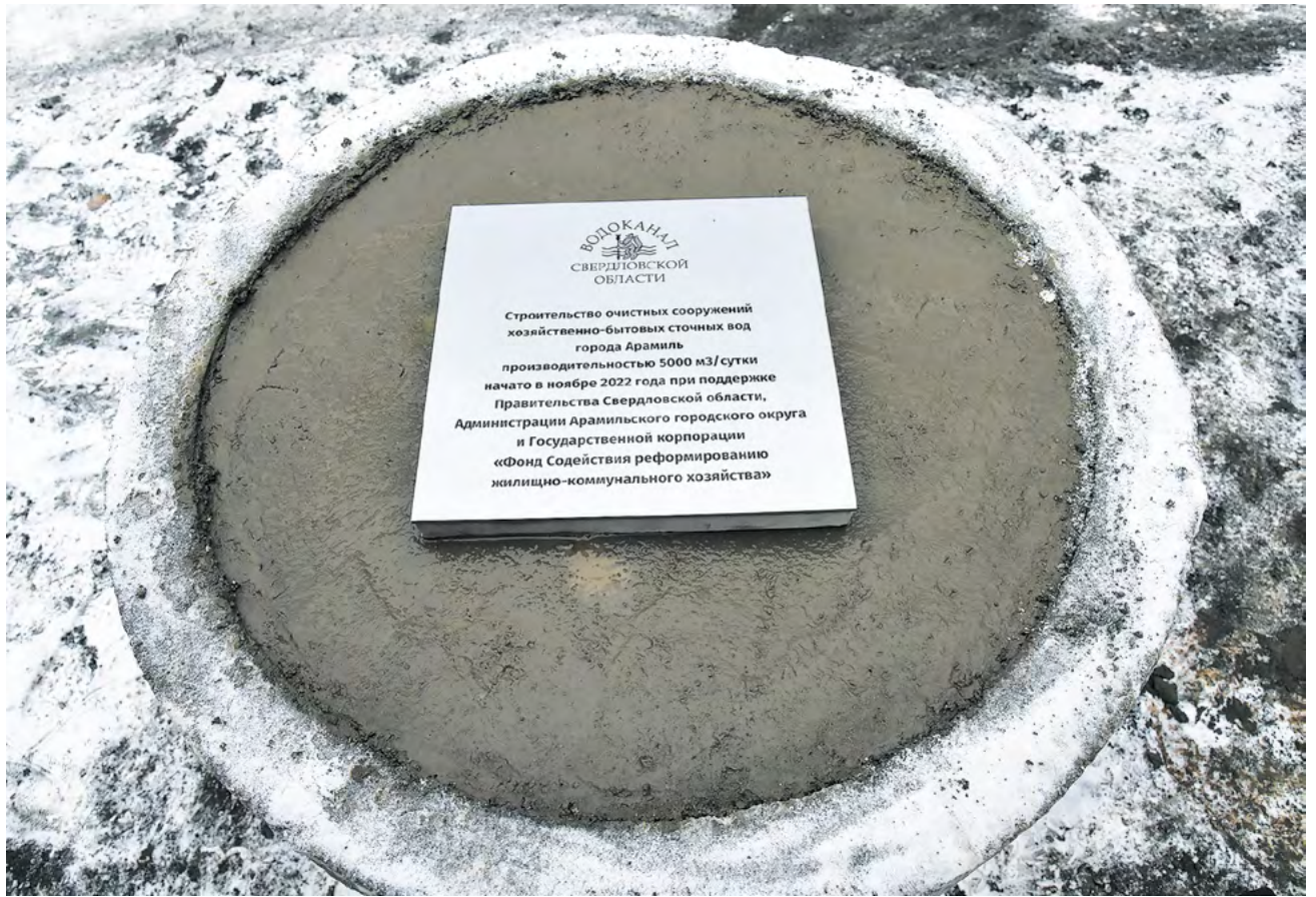
▲ В Арамили стартовало строительство очистных сооружений, средства на строительство которых направлены из фонда национального благосостояния. Фото: Борис Ярков
